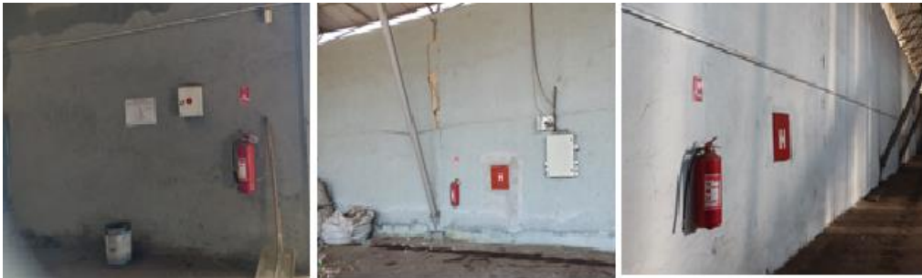
Слика 99 ПП Апарати и сандачиња за прва помош
