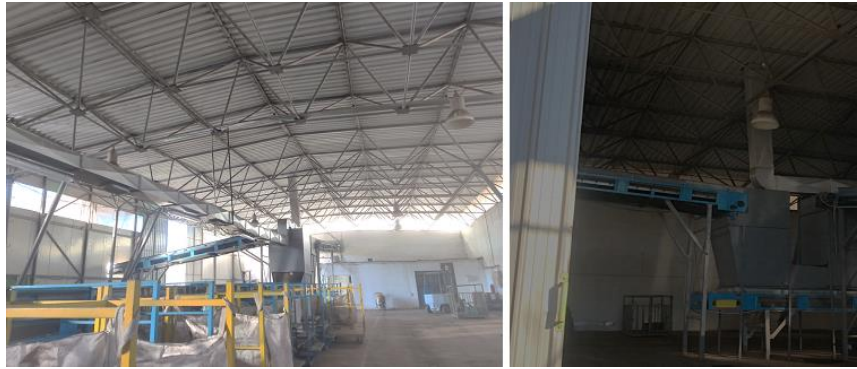
Слика 57 Систем за вентилација и аспирација на емисиите
