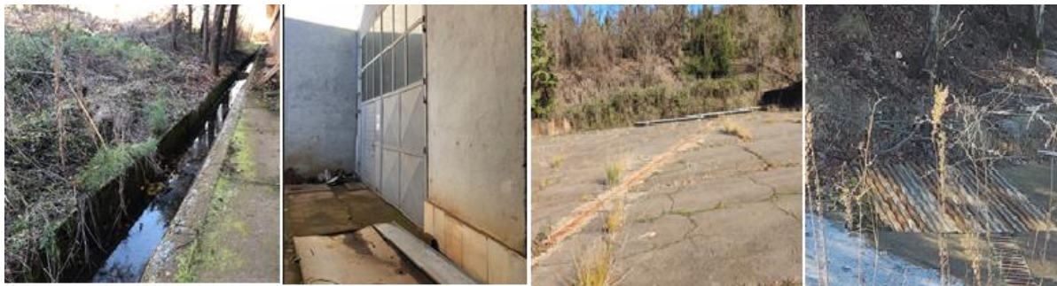
Слика 68 Канали за собирање атмосферски води кои се третираат собирна шахта (покриена)
