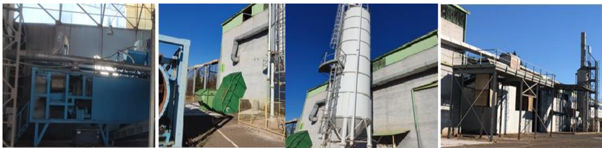
Слика 44 Систем за собирање на пареа која се носи во скруббер (внатре и надвор од халата)
