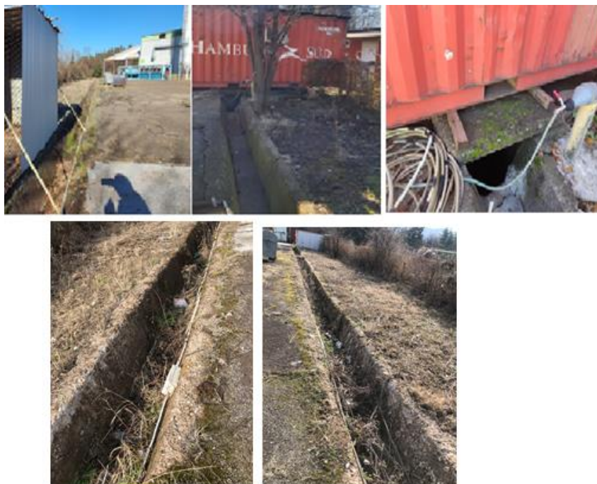
Слика 70 Канал и шахта за собирање атмосферски води кои не се третираат
