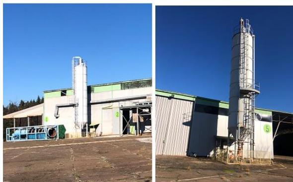
Слика 27 Силоси за складирање адитив (СаО)
