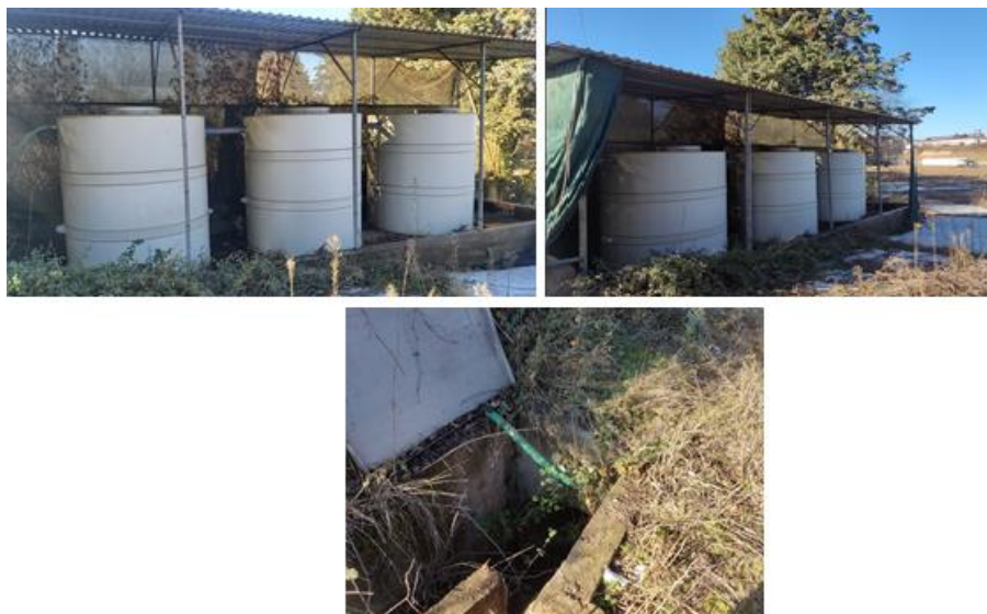
Слика 69 Резервоари за собирање и механички третман на водите и шахта за испуштање третиранни атмосферски води кои се носат во Фени Индустри
